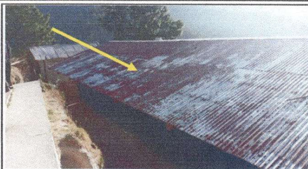
Foto 1: Sustrucción de lámina, por lámina troquelada TT#28
