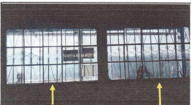
Foto 3: Sustrucción de estructura de metal de ventana
