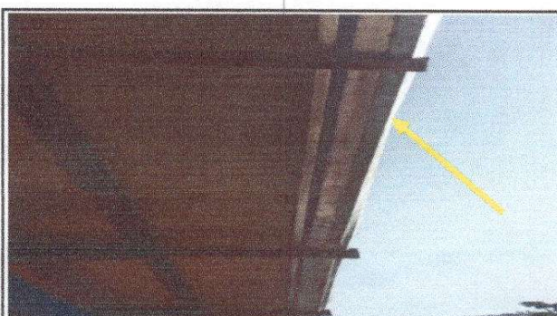
Foto 4: Sustrucción de bajada de agua pluvial
