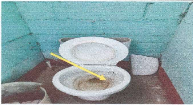
Foto7: Sustitución de inodoro
